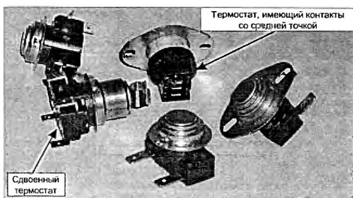
Рис. 9.1. Обычные биметаллические нерегулируемые термостаты
